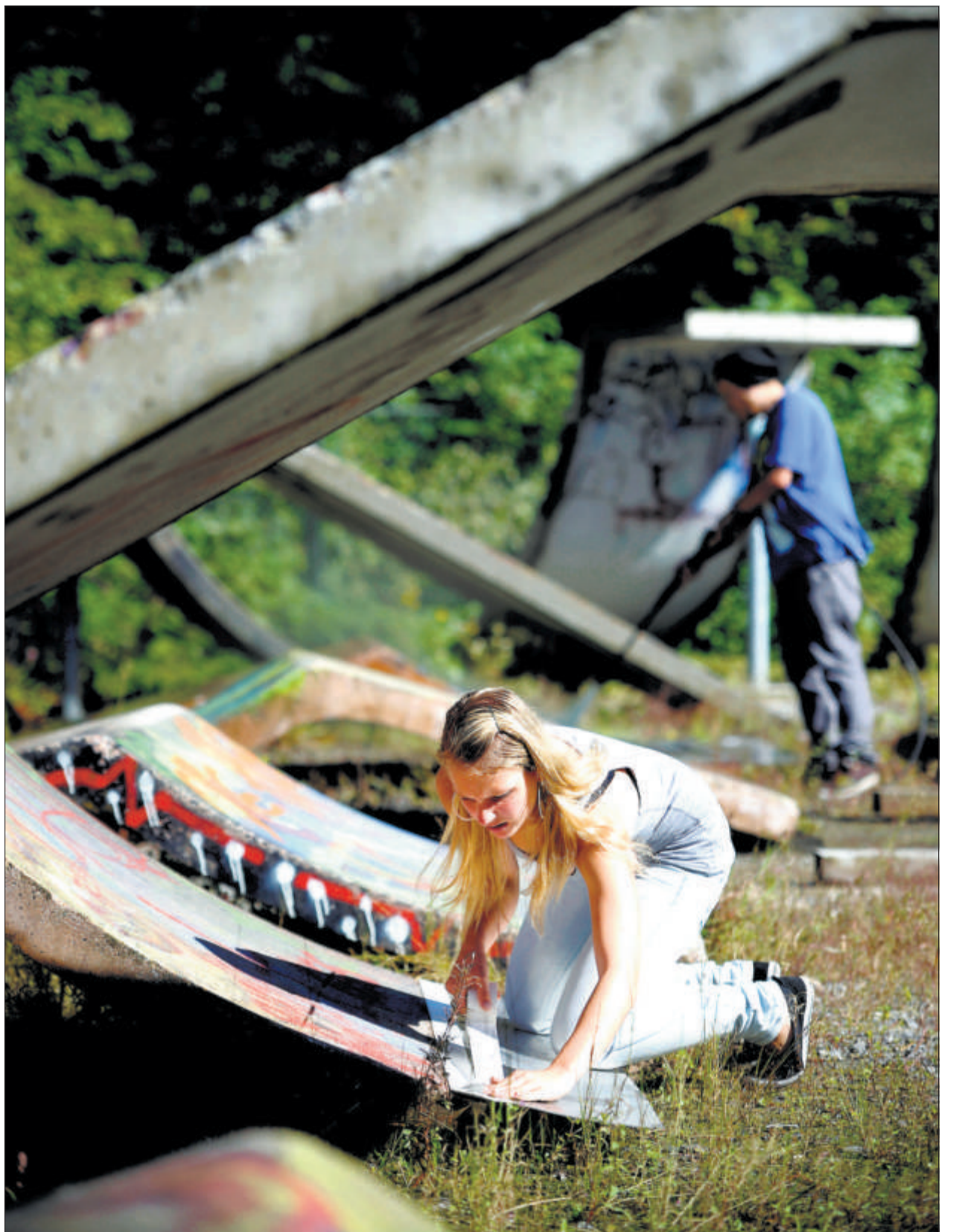
Jugendliche vom Verein Skatepark Kriens sanieren die Betonelemente: Julie Gossweiler (vorne) und Sasha Schmocker.
